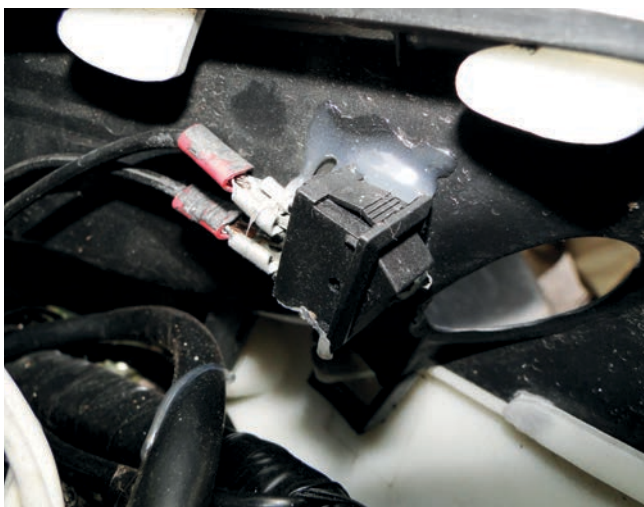
Abbildung 21: Hinter der Verkleidung angebrachter Kippschalter zur Deaktivierung des Drehzahlbegrenzers
