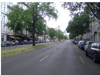
Fahrbahn im Hauptstraßennetz
