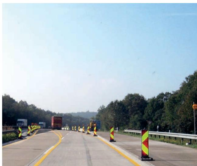
Abbildung 4-6: Pfeilbaken im Bereich der Fahrstreifenüberleitung (links: Zustand weiß; rechts Zustand gelb)
