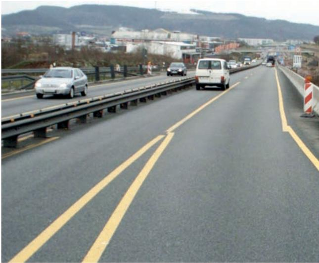
Abbildung 6-7: Ende der linken Fahrbahnrandmarkierung und knickförmiger Übergang in der 1. Überleitung der Baustelle D3
