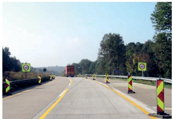
**Abbildung 6-10: Fahrtrichtung 1 Querschnitt 100 m vor der Fahrstreifenüberleitung nach RSA 95 (links) und mit modifizierter Beschilderung (rechts)**
