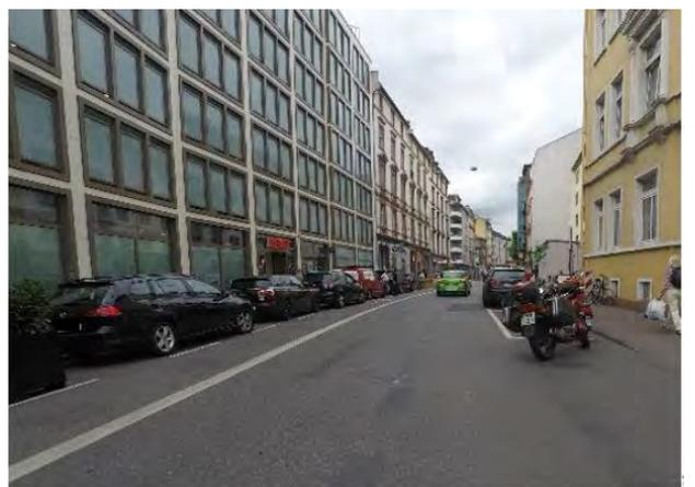
Abbildung 114: Fehlender Sicherheitstrennstreifen
