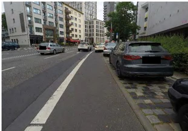
**Abbildung 111:** Fehlender Sicherheitstrennstreifen
